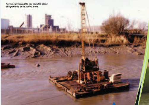
Foreuse préparant la fixation des pieux des pontons de la zone amont.
